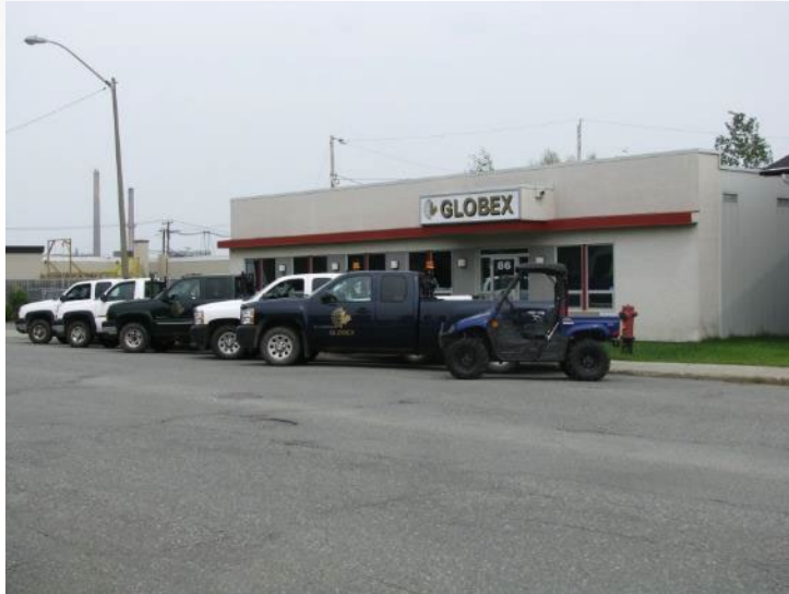
Bureau principal de l'exploration
