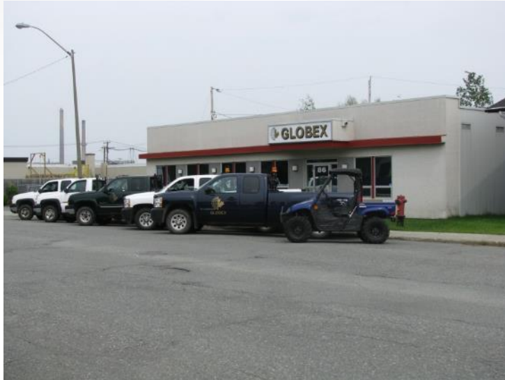
Bureau principal de l'exploration
